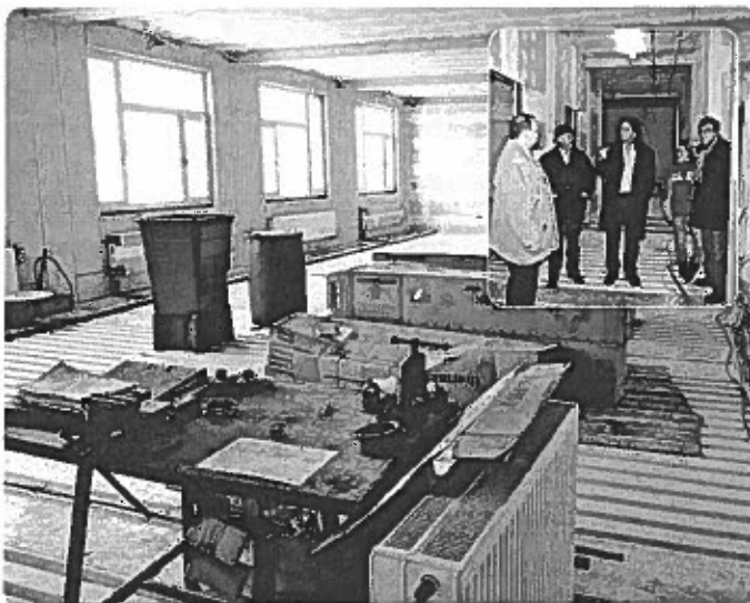
Einen Einblick in den Neubau an der Schönfließer Straße gab der stellvertretende Schulleiter, Hans-Joachim Bork.
